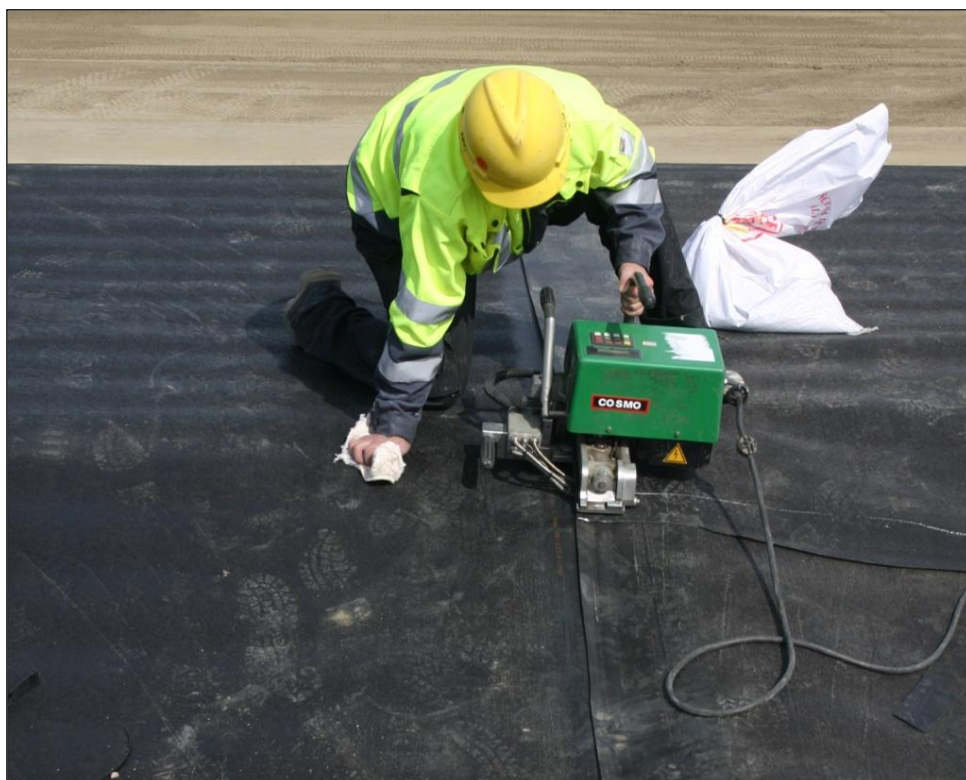
Kuva 4.1. Kuumakiilahitsaus käynnissä työmaalla.
