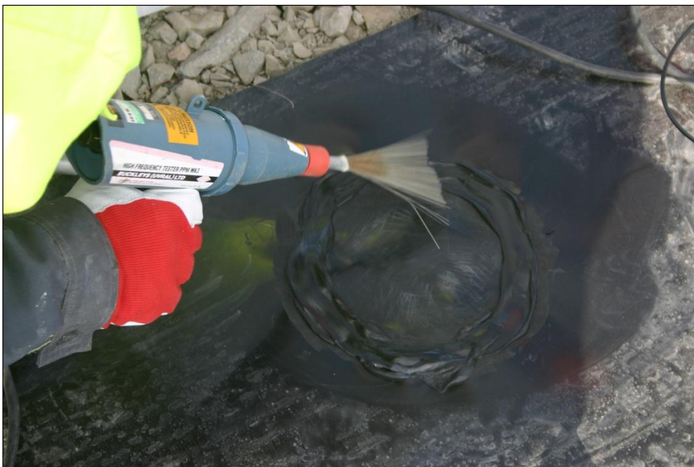
Kuva 4.5. Extrusiohitsaus, sauman kipinäkoe työmaalla.
