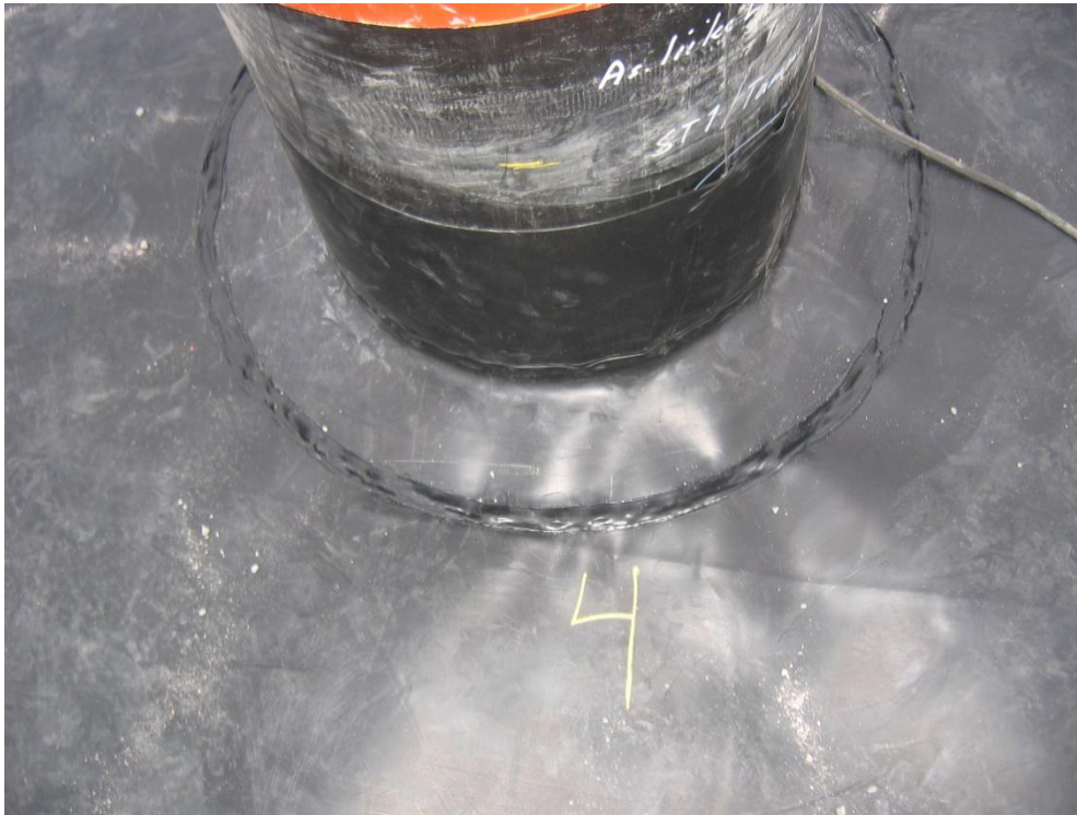
Kuva 4.2. Extrusiohitsauksella tehdyn läpiviennin sauma.
