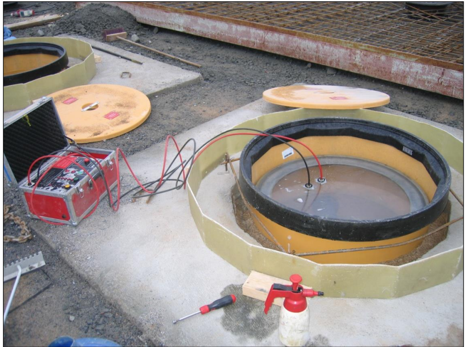
Kuva 5.3. Huoltokaivon painekoe käynnissä työmaalla.
